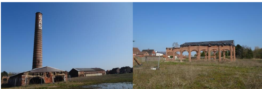
Figuur 5: links: ringoven en gerestaureerde schouw; rechts: arcadebogen van het omlaadstation (april 2019)
