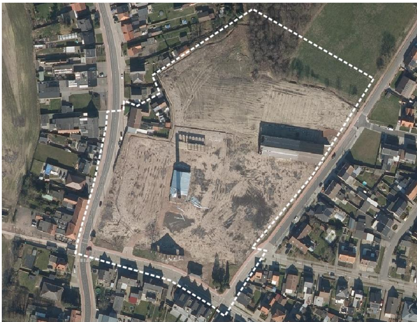
Figuur 2: orthofoto 2018 (na uitvoering sloopwerken)
