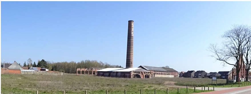
Figuur 4: zicht vanop de hoek Stevennekens – Sint-Jozef op de restanten van het ovengebouw en de productiehal (april 2019)
