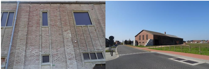
Figuur 11: links: details achtergevel productiegebouw; rechts: inplanting productiegebouw t.o.v. de Hoge Heideweg (april 2019)
