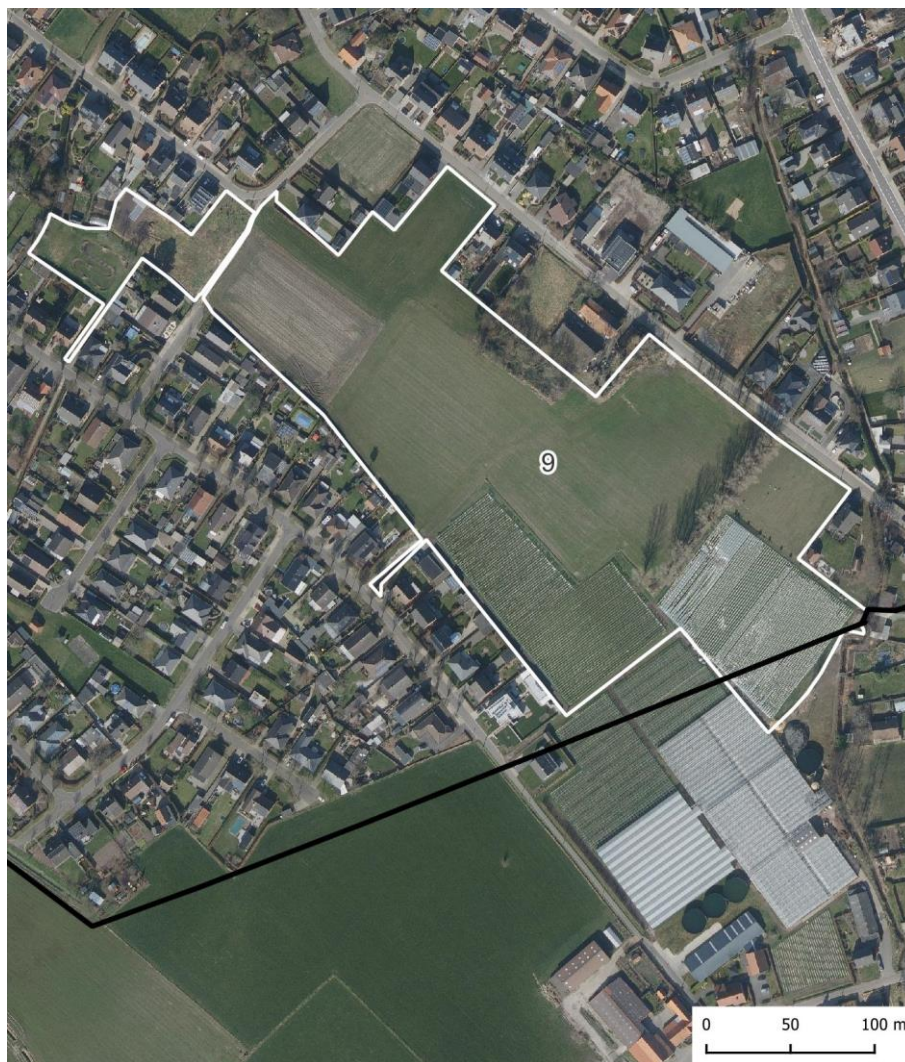
Figuur 12: orthofoto locatie 9 – site Lijsterstraat
